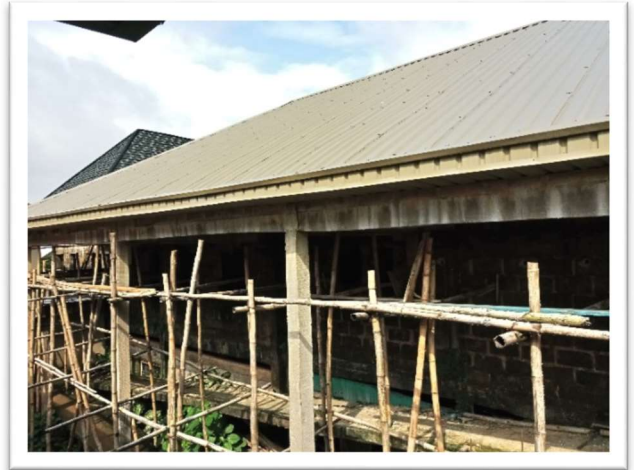
Het nieuwe dak.
